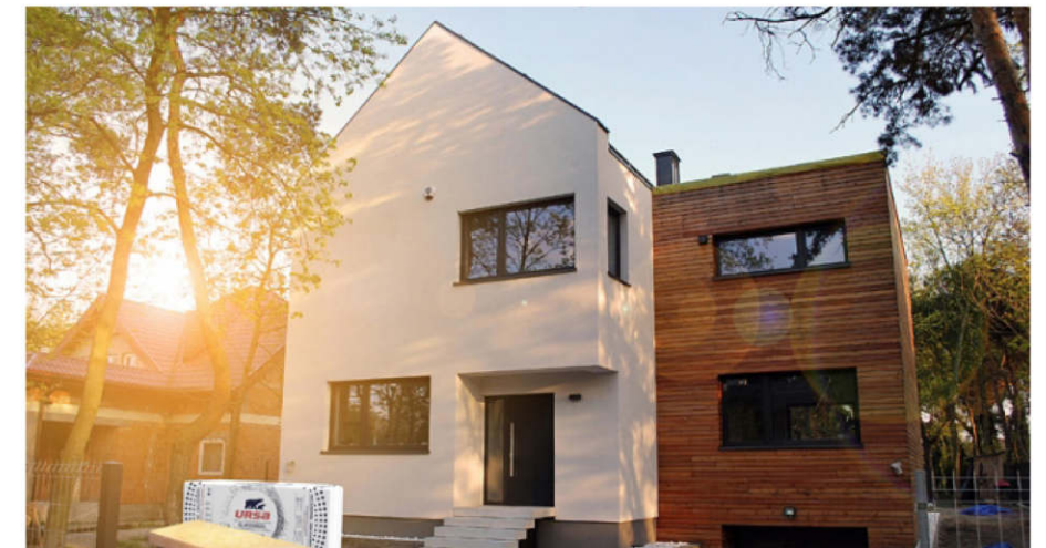
Možnost využití odvětrávané fasády, která skvěle dýchá a tlumí nežádoucí hluk
