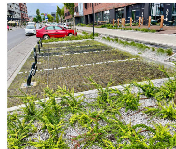
Parkovací plocha zpevněná zatravněvacími mřížkami [Kraków, Polsko]
