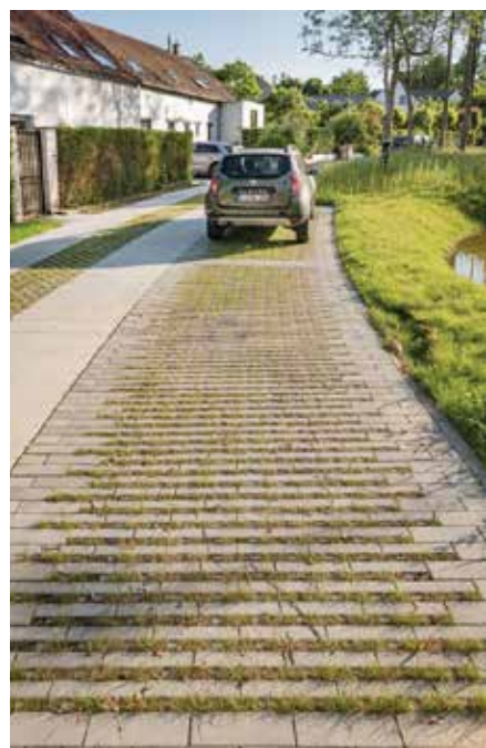
Parkovací plocha doplněna zatravnňovací betonovou dlažbou se spárou pro zeminu a travinu [Bruggy, Belgie]
